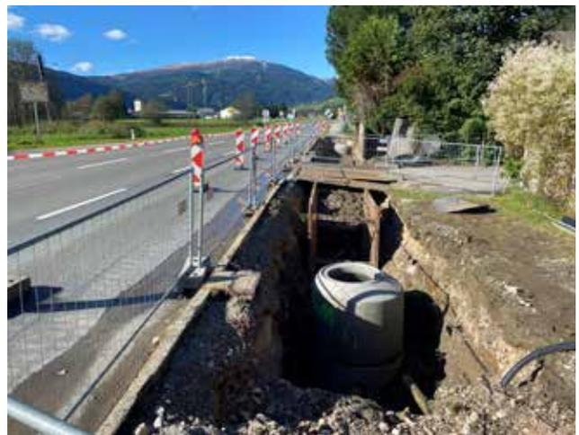
Die neue Wasserleitung musste unter der Bundesstraße durchgepresst werden. Auch hier schreiten die Arbeiten voran und werden ebenfalls dieses Jahr abgeschlossen werden. Ich darf betonen, dass die Sanierung dringend erforderlich ist und somit die Sicherheit und Infrastruktur der Gemeinde verbessert wird. Immer wieder kommen „kleinere“ Projekte betreffend Entwässerung dazu und diese werden begleitend umgesetzt, weil es im gegenständlichen Baulos Sinn macht.
